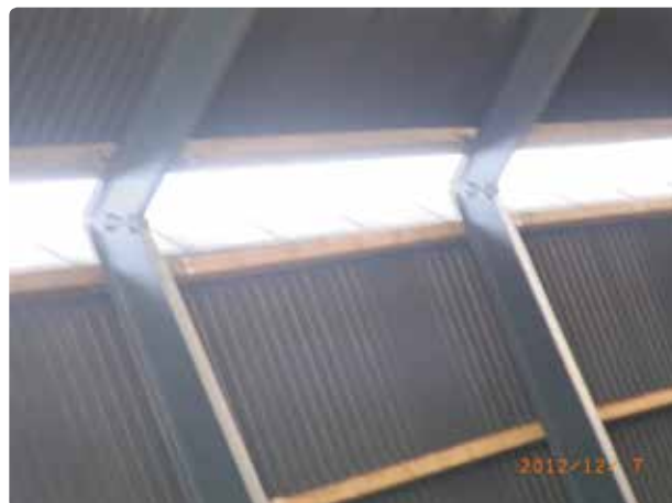
Figur 2.3 Åben ventilationskip er billigt - og okay, når der ikke ligger dyr lige under.
